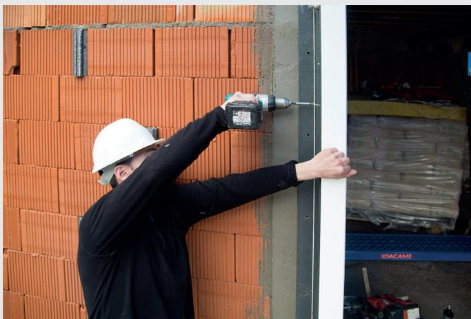
Figura 10: Fijación ventana a Termoarcilla.
