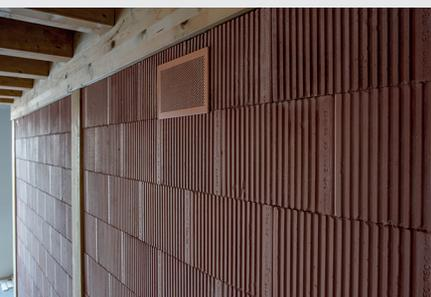
Figura 17: Detalle muro Termoarcilla como interiorismo, mismo acabado que en uso estructural.
